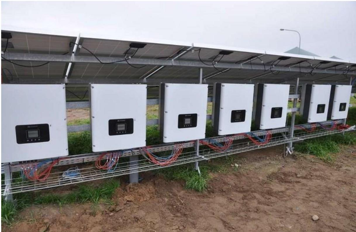
Abb. 1 Wechselrichter unterhalb der Modulreihen angebracht
