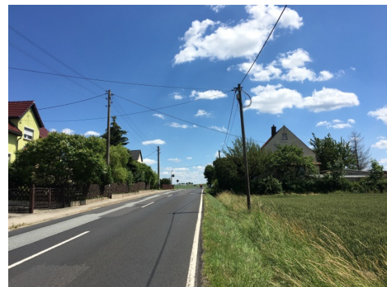
Abb: 5 Ansicht von Nordwesten
