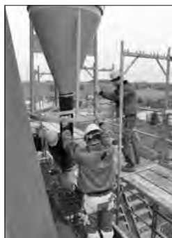
Die Mitarbeiter der Firma Heidrich beim Gießen des Ringankers Foto: J. Christoph, Büro Risch
