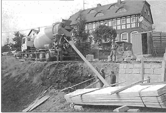
„Stützmauerbau“ an der Dorfstraße in Spitzkunnersdorf bei Haus Nr. 58
