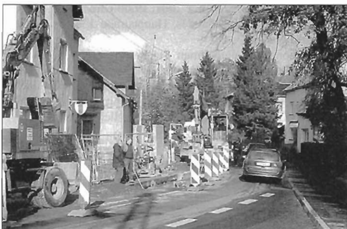
Kanalbau im November 2001 – 1. Bauabschnitt
