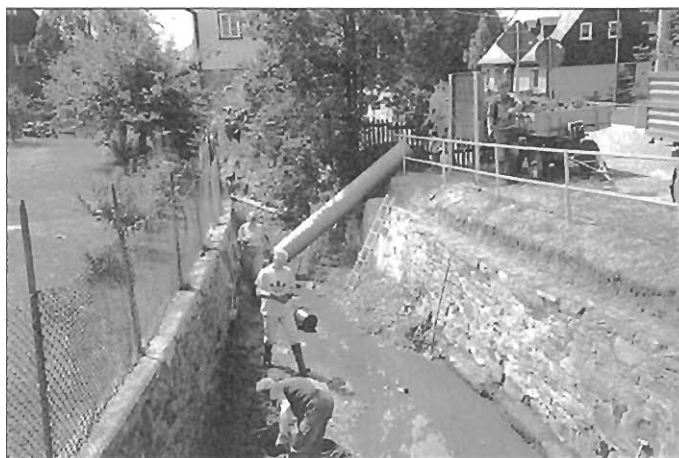
ABM – Am Wehr, Friedensstraße
