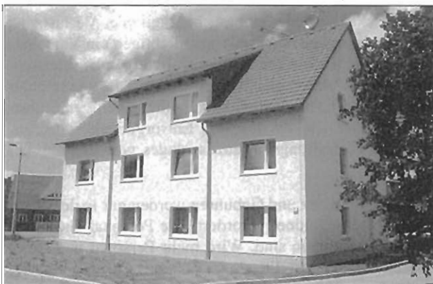
Neugebautes Wohnhaus an der Mittelstraße
