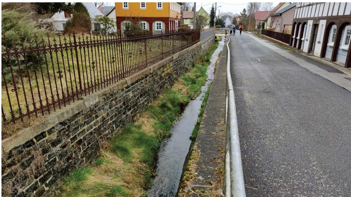
Abbildung 7.26: Blick von km 4+200 in Fließrichtung, etwa 50 m vor der Wefagraben-Mündung
