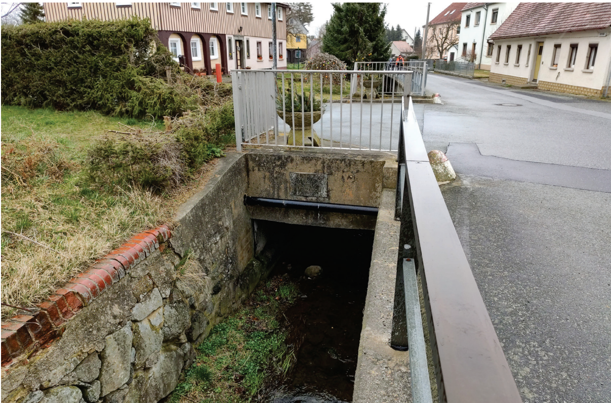
Abbildung 7.24: Einlauf der Brücke Nr. 30 Weberstraße bei km 4+337
