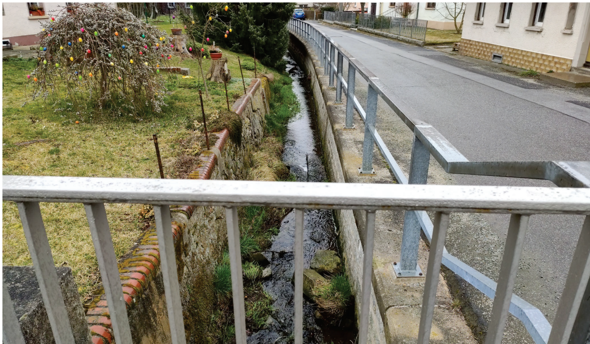
Abbildung 7.25: Blick vom Auslauf der Brücke Nr. 30 Weberstraße bei km 4+327 in Fließrichtung
