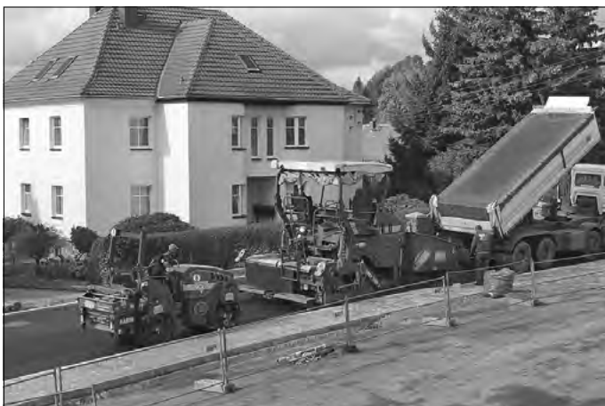
Bau der Hauptstraße in Leutersdorf
