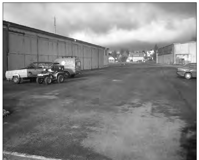
Deckenbau Garagenvorplatz Gewerbegebiet Leutersdorf
