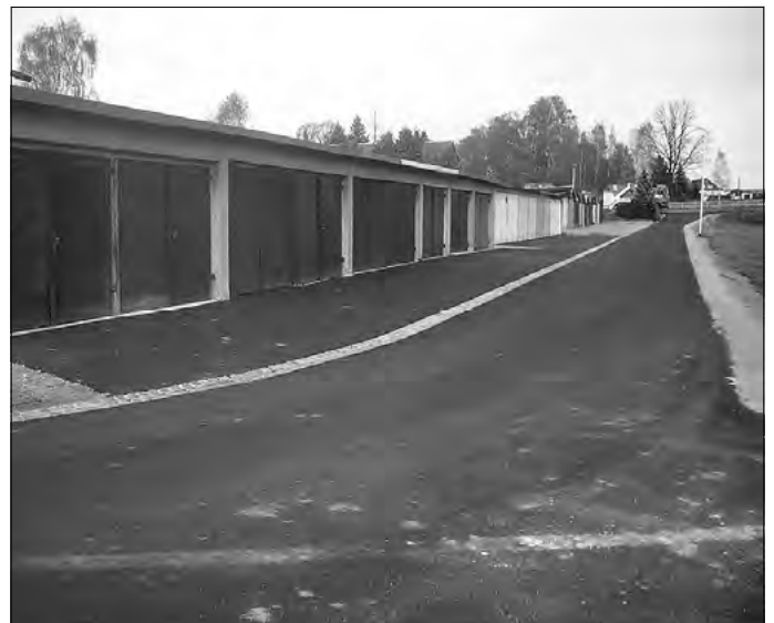
Deckenbau Kastanienweg Leutersdorf
