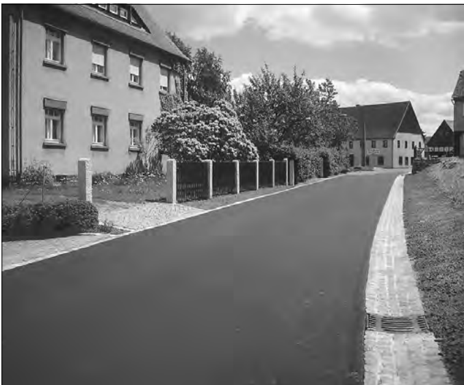
Straßendeckenbau Poststr. Spitzkunnersdorf
