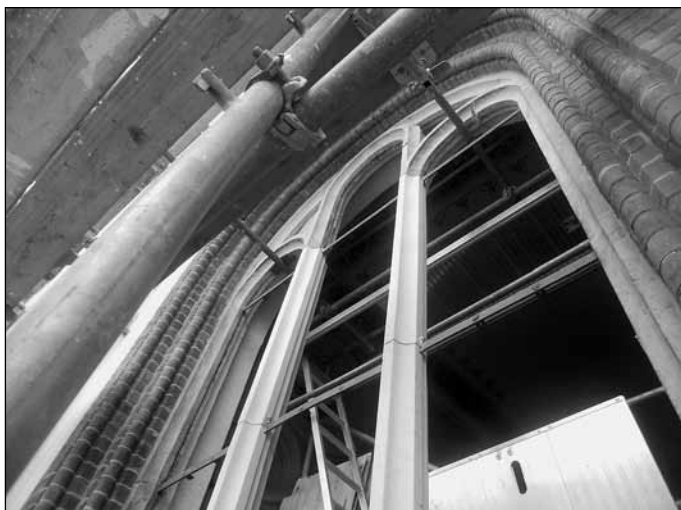
Neue Sandsteinrippen an einem der Kirchenfenster
