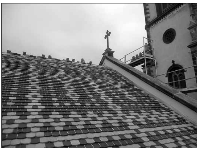
Blick über das fast fertige neue Dach zum Kirchturm, die Firststeine fehlen noch
