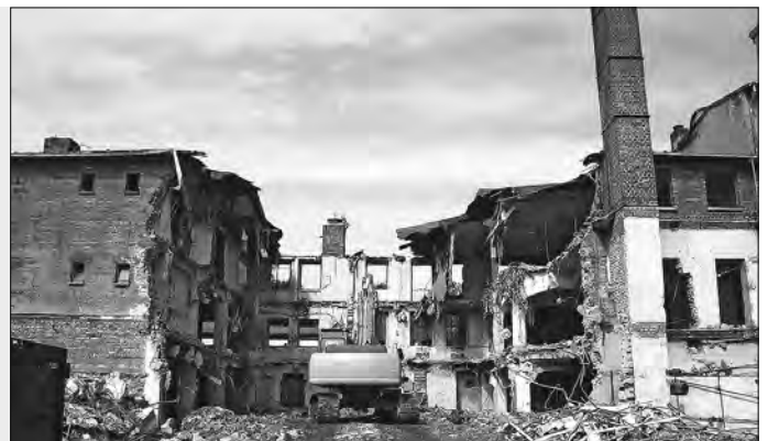
Abrissarbeiten im Gewerbegebiet Geschw.-Scholl-Str.
