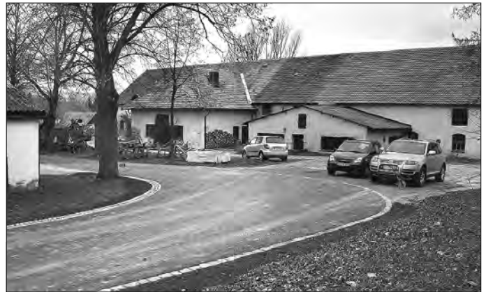
Straßendecke Am Hofeteich
