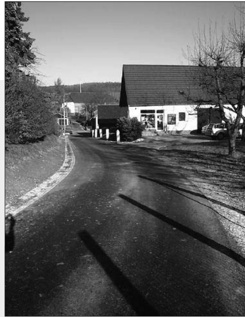
Straßen- decken- erneuerung Zur Hohle
