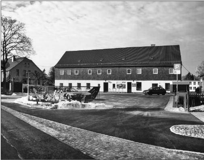
Ausbau des Vorplatzes
