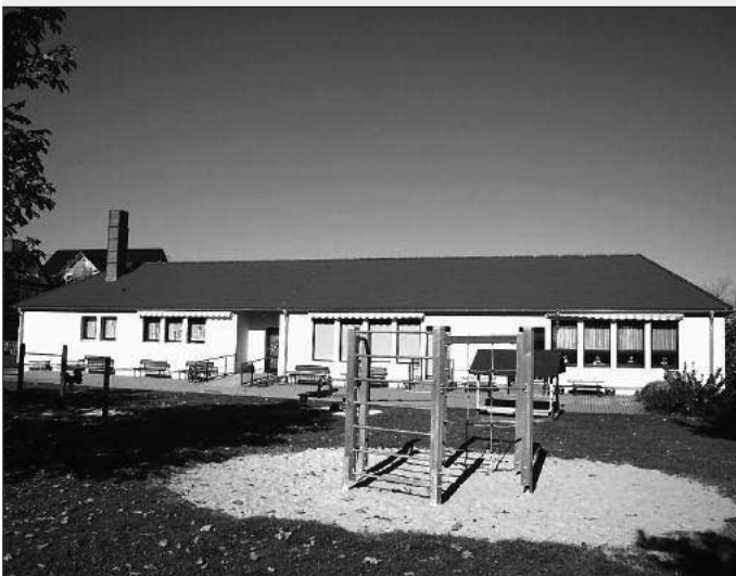
Sanierung des Kindergartens „Forstenzwerge“
