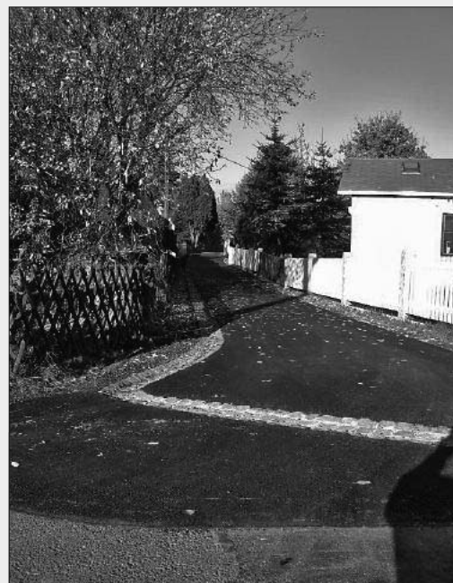
Erneuerung der Straßen- decke Niedere Zeile
