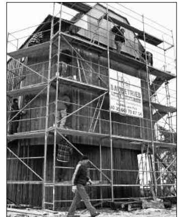
10.12.2005: Anbringen der Außenverschalung Foto: Bartsch
