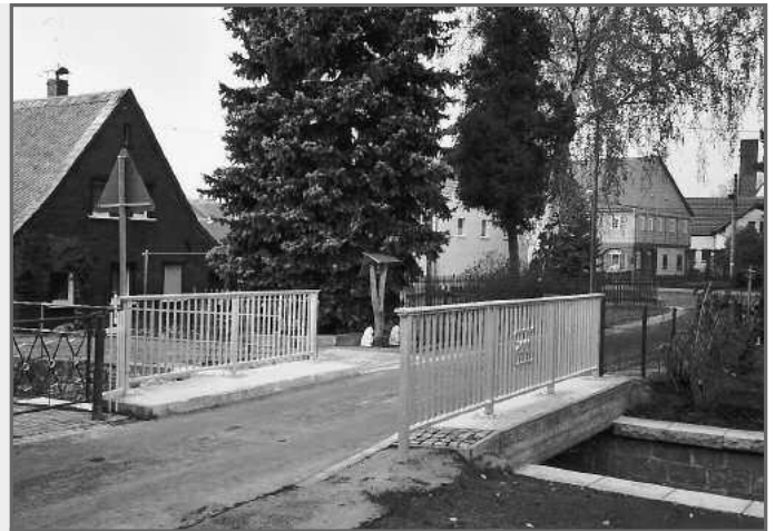
Brücke Kretschamweg, Leutersdorf
