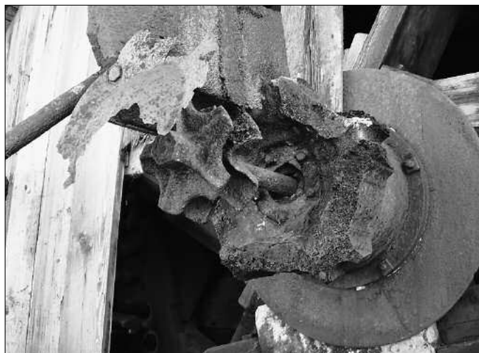
Sandsteinlager, das den Wellkopf antrieb Foto: M. Bartsch
